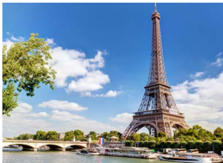
Tidligere opførte man stålkonstruktioner i almindeligt stål, som er særdeles holdbart, hvis man vedligeholder det. Eiffeltårnet er fra 1889 og viser således ingen tegn på nedbrud. Eiffeltårnet følger et vedligeholdelsesprogram, hvor det gennemgås hvert 7. år og sandblæses og males hvor der er behov.
