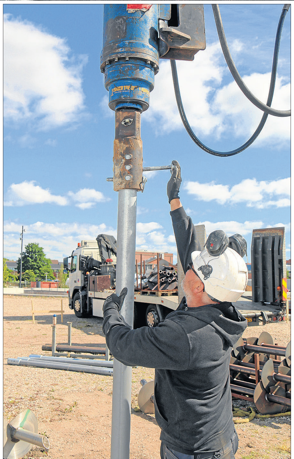
Skruppælene forlænges i takt med, at de bores ned i undergrunden. Iskruningsmomentet fortæller Uretek-folkene, hvornår pælene har optimal træk- og trykstyrke. (PR-foto)
